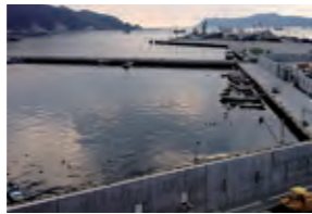
岩手県釜石市釜石港の眺め。埠頭や防潮堤の復旧も進み、重機を見かけることも減りつつある。
