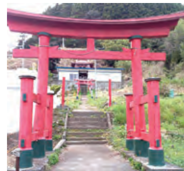
岩手県沿岸部のある氏神を祀る神社。氏子が集う集会所も見え、大津波に襲われながらも、沿岸部の神社の本殿はほとんど無傷で生き残っている。
