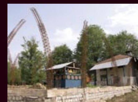
同郡の建築途中の聖廟。資金不足から工事が止まっているとのこと。寄付を呼びかけているが思うようには集まらないとのこと
