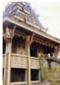
ラオスの保管庫(パゴダ)の外観 [1992]
