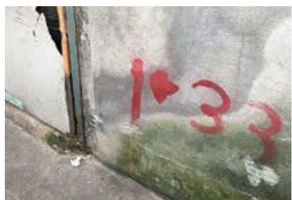
運河拡幅のための立ち退きライン
